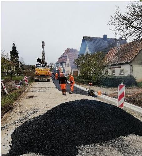
Die Telekom verlegt die Leerrohre für das Glasfasernetz.
